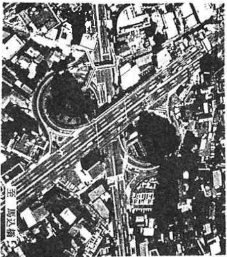
上から見た松原橋 (写真提供：大田区)
